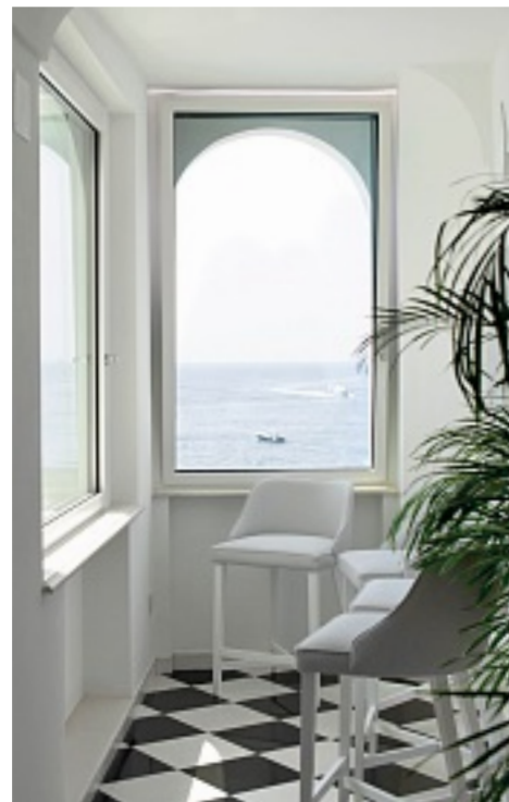
PALAZZO DON SALVATORE, AMALFI Per la ristrutturazione del boutique hotel affacciato sul Golfo, l'architetto John Amendola ha optato per uno stile essenziale. I serramenti di alluminio Schüco , installati nelle zone comuni e nelle stanze, sono stati scelti per i profili sottili, personalizzati in Ral 9010 opaco e in grado di abbattere il rumore fino a 49 dB. • Architect John Amendola opted for a simple style for his renovation of this boutique hotel overlooking the bay. The Schüco aluminium frames, installed in the communal areas and in the rooms, were chosen for their thin profiles, customised in matt Ral 9010 and able to reduce noise to 49 dB. schueco.com
